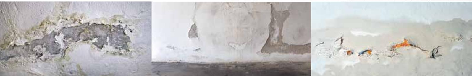
Il riconoscimento della natura e dell'entità delle cavillature è fondamentale per la scelta dell'ideale ciclo di finitura. La distinzione iniziale da farsi è tra le cavillature a ragnatela, date dal ritiro plastico dell'intonaco, e le cavillature/lesioni lineari. Per il secondo tipo è indispensabile verificarne l'origine in modo da essere certi che non nascondano ben più gravi problematiche strutturali.
